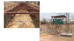
ลึกเกิน 1.2 เมตร ต้องมีบันไดหนีภัยและหมวกกันน็อคหรือมาตรการดินพัง
